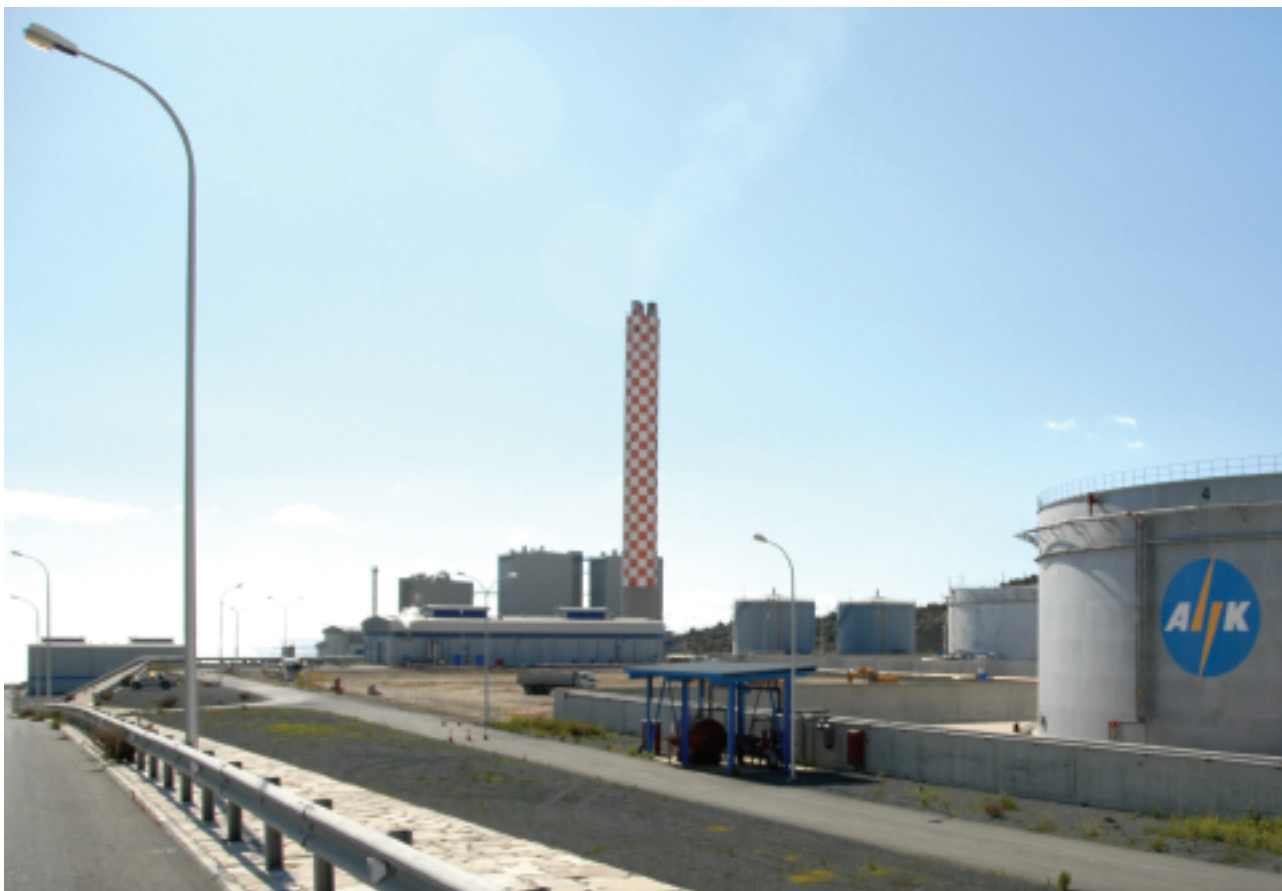
Ηλεκτροπαραγωγός Σταθμός Βασιλικού
