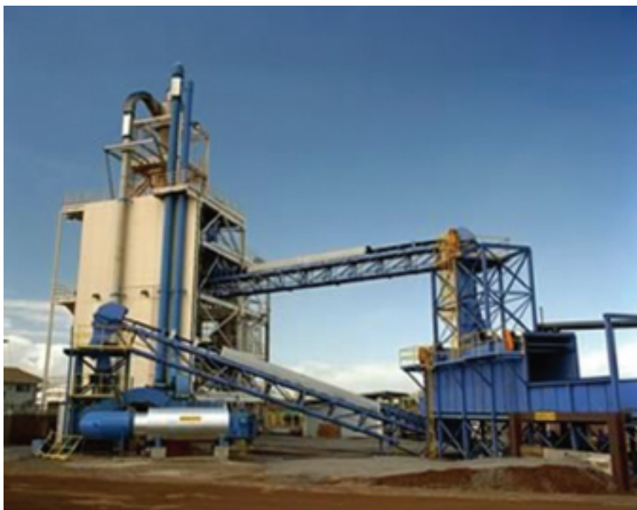
Ηλεκτροπαραγωγός Σταθμός Βιομάζας
