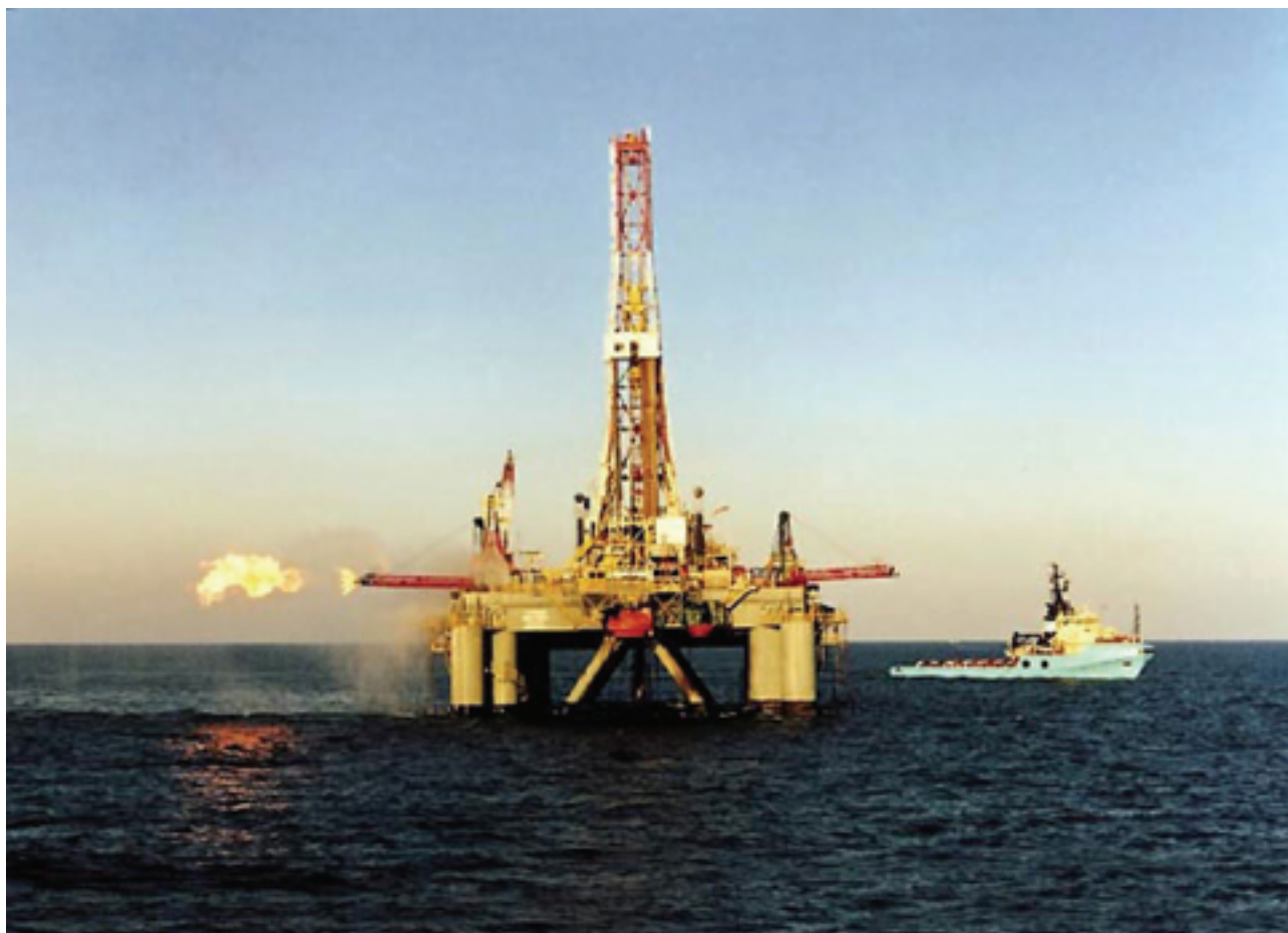
Θαλάσσια πλατφόρμα για ανόρυξη Φυσικού Αερίου. Η οδηγία 2004/67/ΕΚ είναι σχετική με τα μέτρα διασφάλισης του εφοδιασμού με Φυσικό Αέριο. Η ΠΑΕΚ διαβουλεύτηκε με τους αρμόδιους φορείς για Νομοσχέδιο που στοχεύει στην εναρμόνιση της νομοθεσίας μας με την πιο πάνω Οδηγία.
