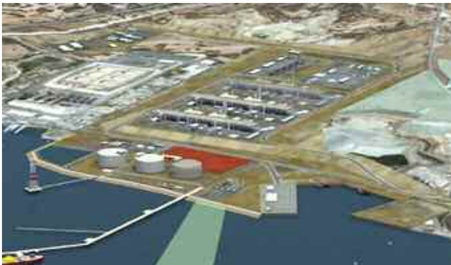
Τερματικό Υγροποίησης Φυσικού Αερίου το οποίο περιλαμβάνει και τις εγκαταστάσεις αποθήκευσης και εξαγωγής Υγροποιημένου Φυσικού Αερίου
