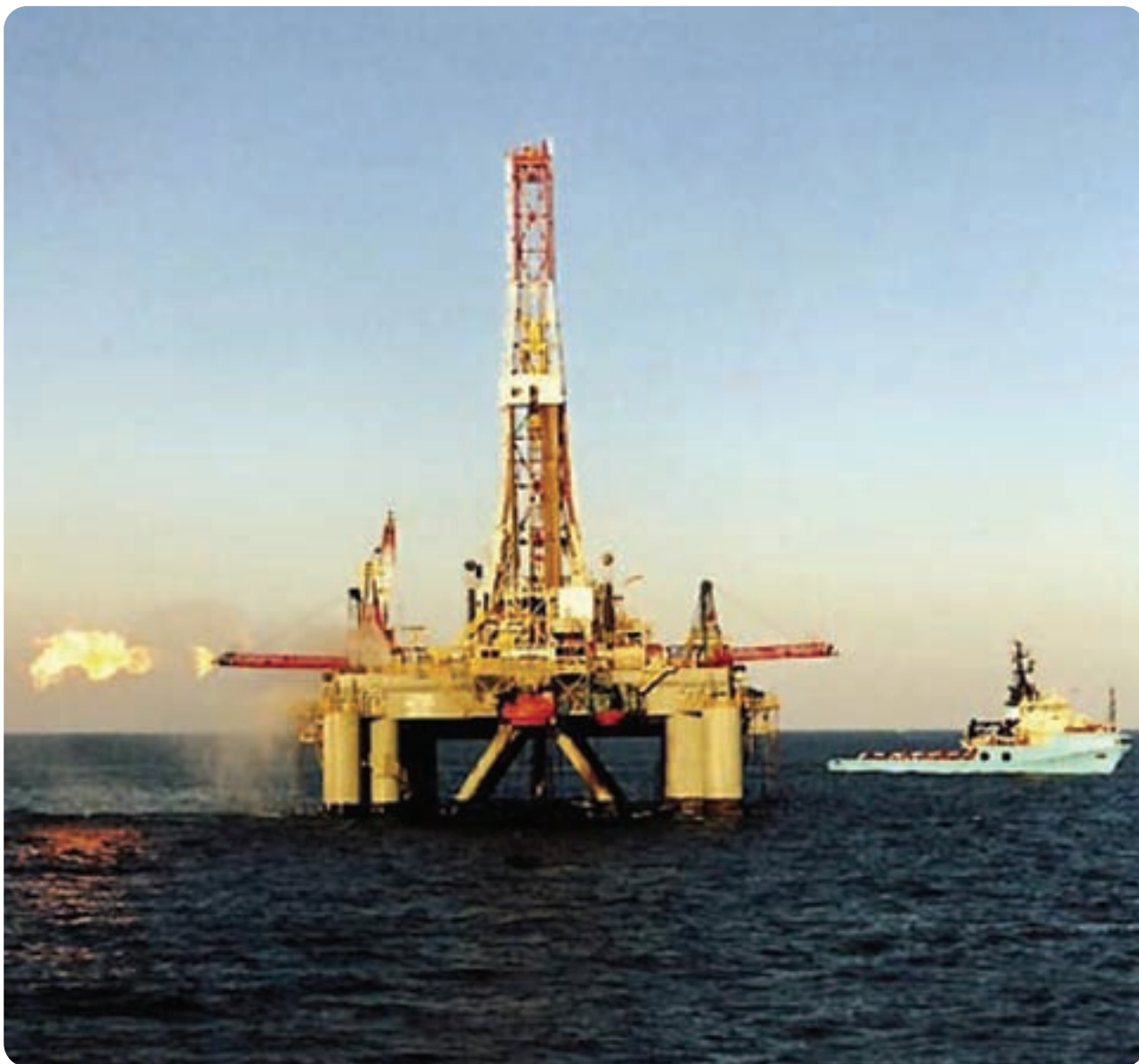
Πλωτή Μονάδα άντλησης Φυσικού Αερίου
