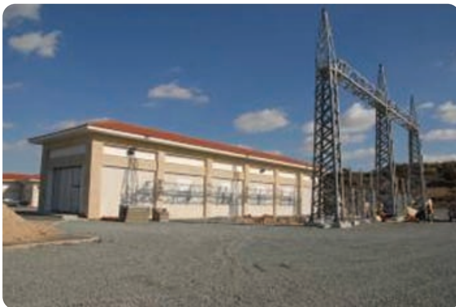
Οι κτηριακές εγκαταστάσεις του νέου Υποσταθμού Μεταφοράς "Τσέρι"
