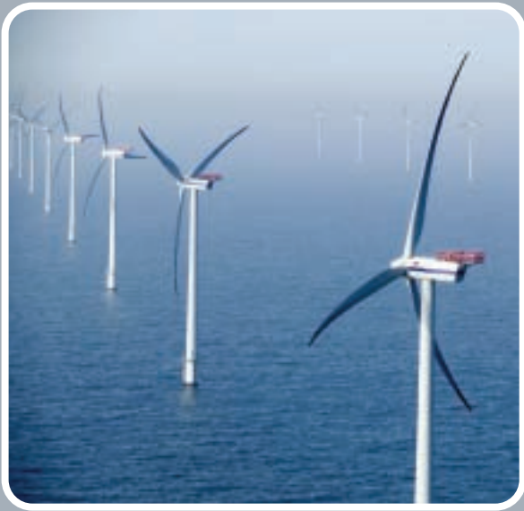
Άποψη Θαλάσσιου Αιολικού Πάρκου
