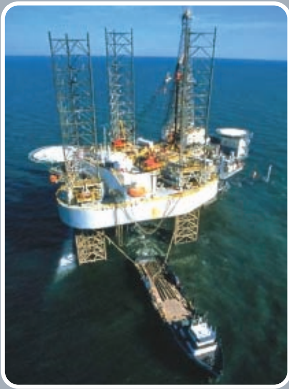
Πλωτή Μονάδα άντλησης Φυσικού Αερίου
