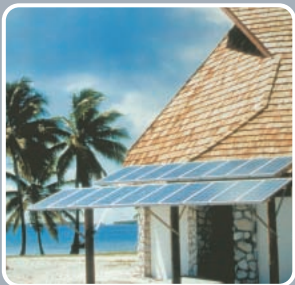
Εγκατάσταση φωτοβολταϊκών πλαισίων σε οικία
