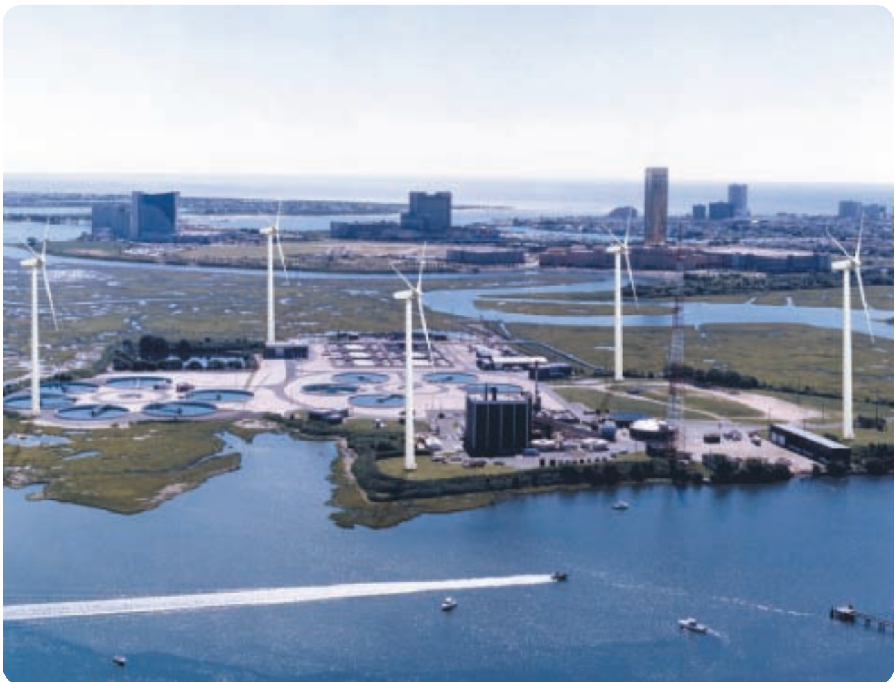
Αιολικό Πάρκο στην πόλη Τζέρσεϊ Ατλάντικ Αμερικής, που ηλεκτροδοτεί εργοστάσιο επεξεργασίας λιμμάτων
