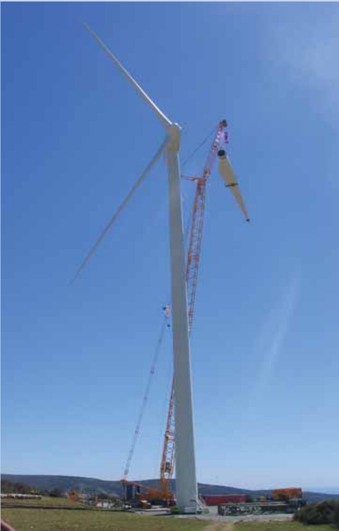
Στιγμιότυπο από την κατασκευή ανεμογεννήτριας στους Ορείτες
