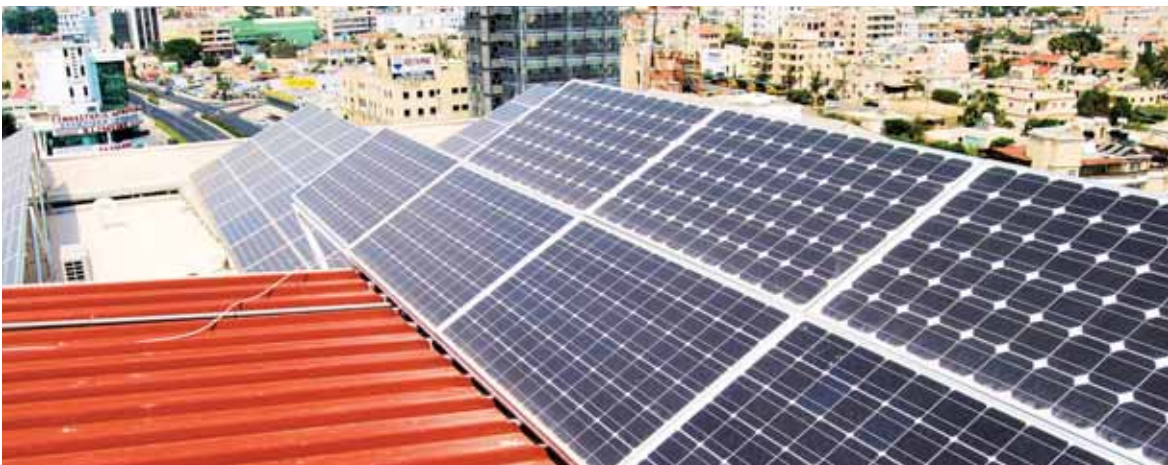
Εγκατάσταση Φωτοβολταϊκού Συστήματος στην οροφή κτηρίου στη Λάρνακα
