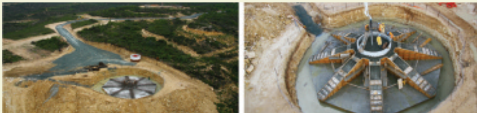
Από τις εργασίες κατασκευής του πρώτου Αιολικού Πάρκου στην τοποθεσία "Ορείτες" στην περιοχή των Χωριών Πάνω Αρχιμανδρίτα, Κούκλια και Αιέκτωρας των επαρχιών Πάφου και Λεμεσού.
