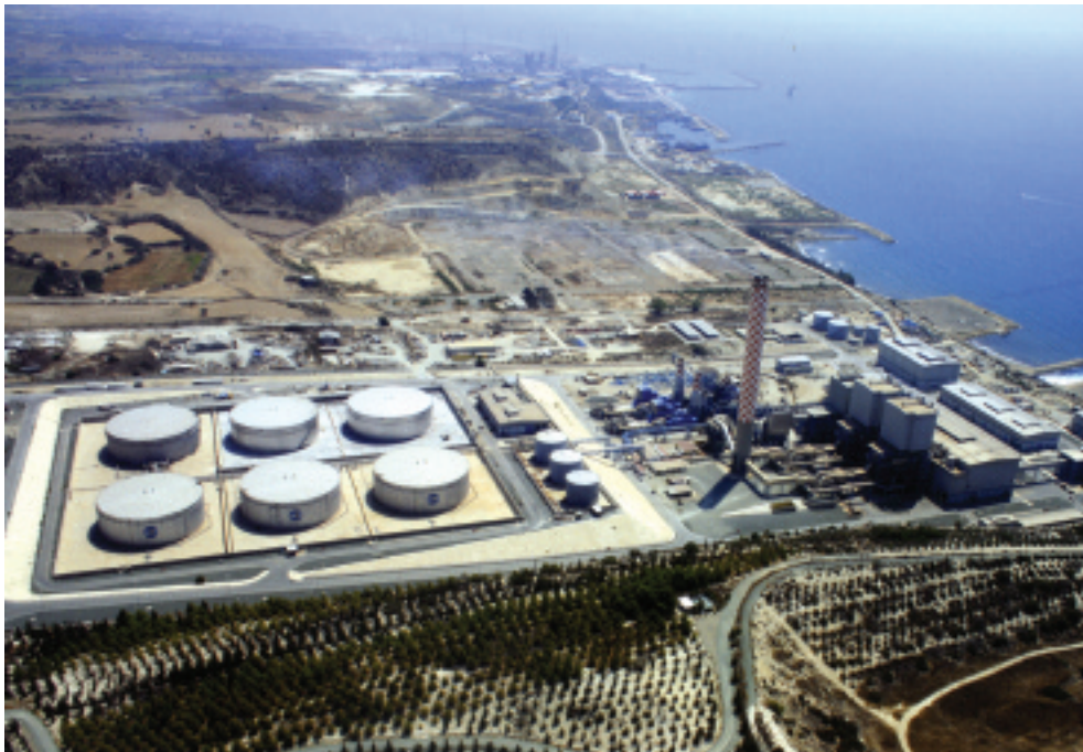
Εναέρια φωτογραφία του Ηλεκτροπαραγωγού Σταθμού της ΑΗΚ στο Βασιλικό
